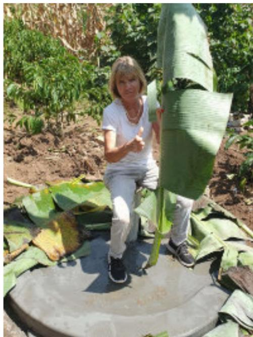
Der Beton muss erst noch trocknen. Damit der Beton nicht zu schnell trocknet und damit rissig wird, wird er mit Bananenblätter abgedeckt
